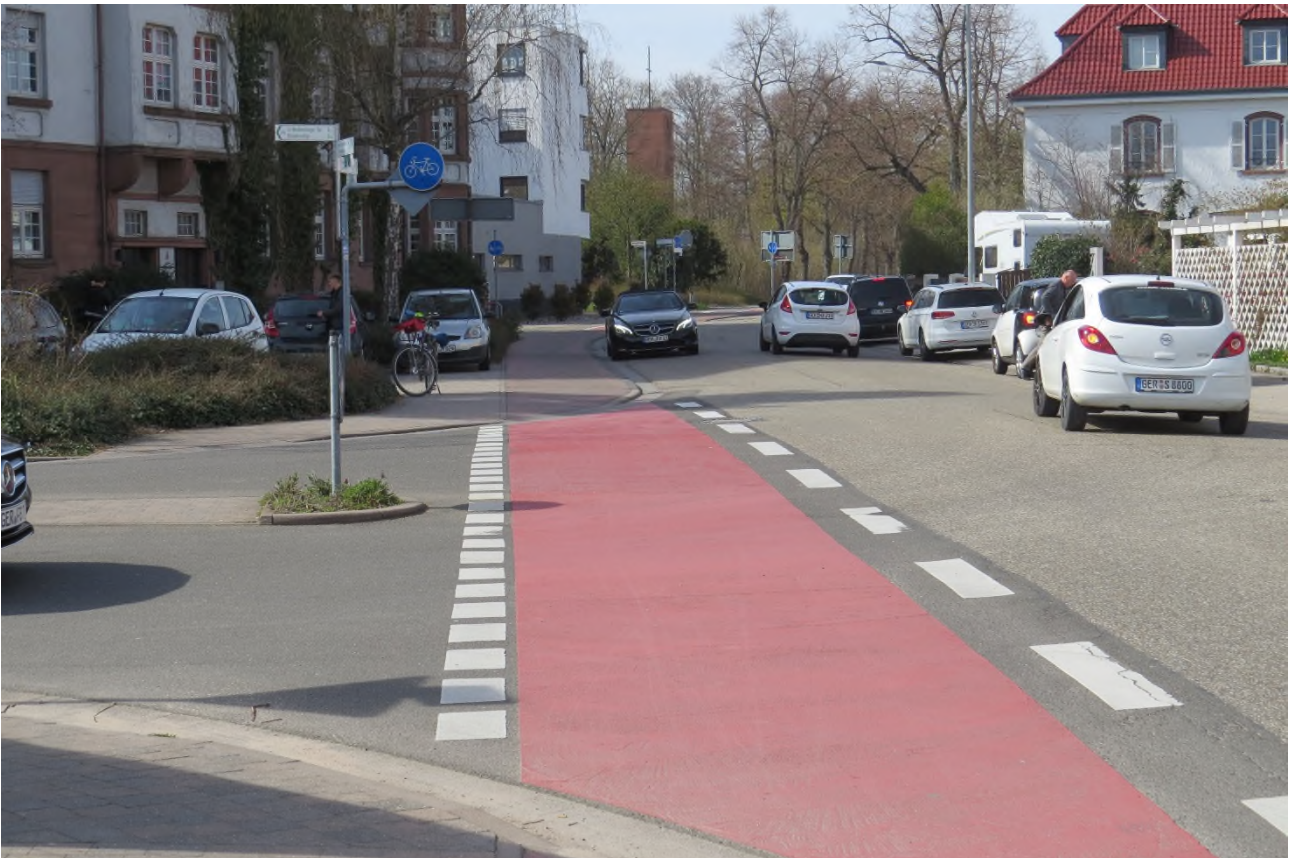
Ausbau der Hauptstraße in Germersheim 2006: auf Anregung des ADFC Germersheim mit gerader Radwegfurt ohne Versatz
